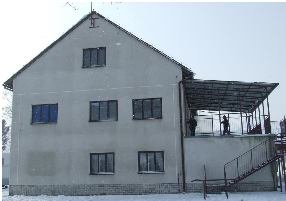
Zdjęcie: 4 Elewacja Boczna – prawa strona budynku
