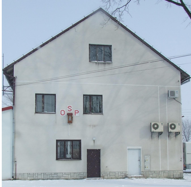
Zdjęcie: 3 Elewacja Boczna – lewa strona budynku.
